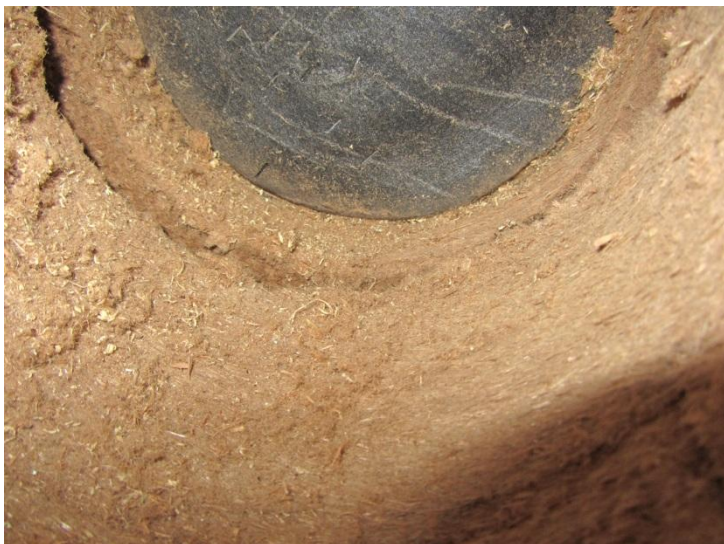
Figur 3.1.13.6 – Provtagning i sovrum nordväst, norra väggen, nära tak.
