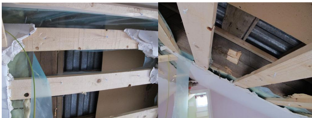
Figur 3.1.1.8. - Konstruktion och märke efter provtagning.
