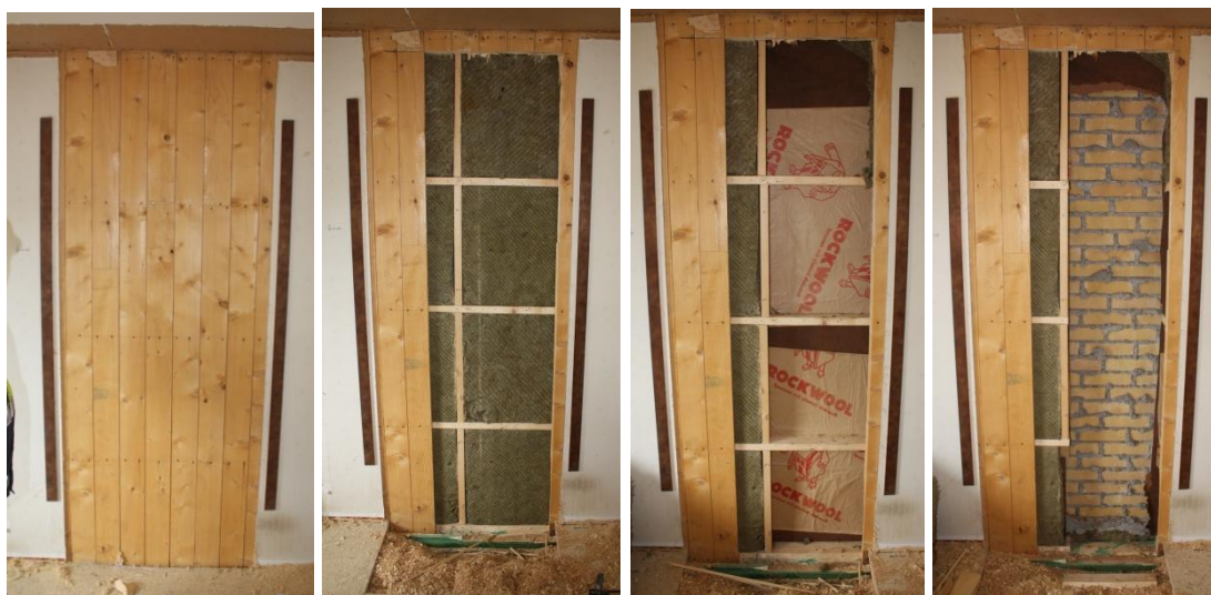
Figur 3.1.6.2 - Stående spontade plank, mineralull, härdad board och mineralullsemballage, murverk.
