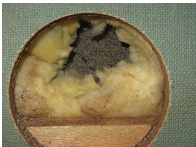
Figur 3.1.12.6 – Provtagning i hall i norr mitt under fönster. Uppmätt fuktkvot i innerregel 9%.
