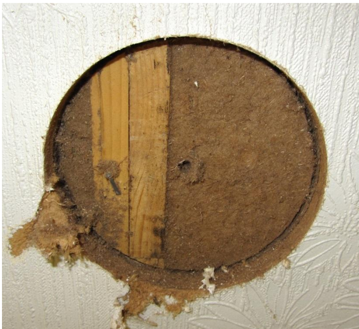
Figur 3.1.13.7 – Provtagning i vardagsrum i söder. Uppmätt fuktkvot i innerregel 8%.
