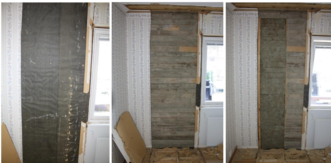
Figur 3.1.2.2 - Under mjuk träfiberskiva hittas: förhydringspapp, liggande återanvänt spontad formplank, mineralullsisolering.
