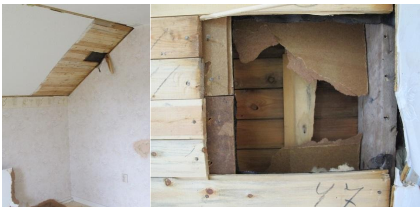
Figur 3.1.14.2 – Parallelltak upptaget fram till råspont.
