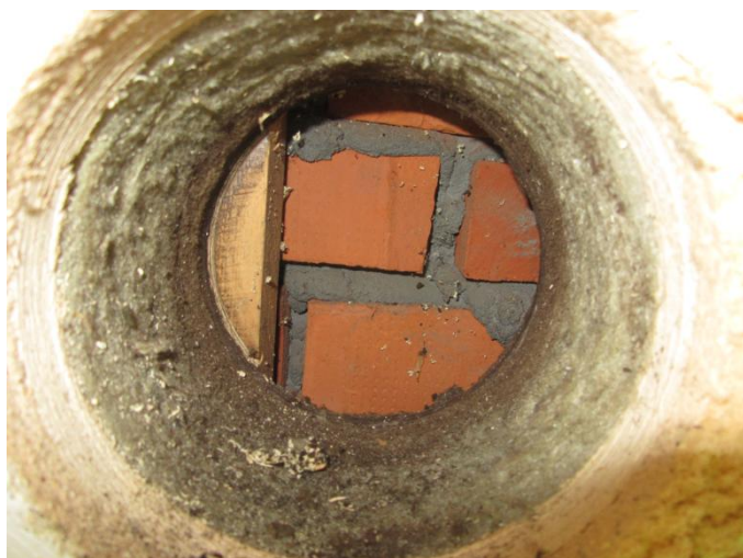
Figur 3.1.11.8 – Provtagning i vardagsrum i väster intill fönster. Uppmätt fuktkvot i spont och spallläkt 8%.
