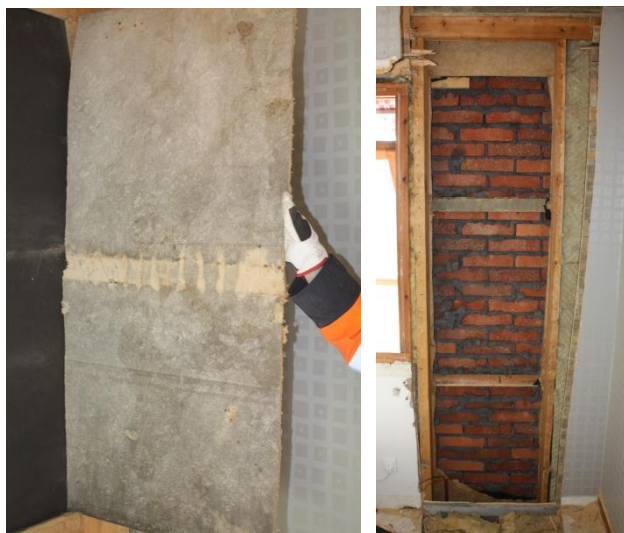
Figur 3.1.3.3 - Den mjuka träfiberskivans baksida är missfärgad och bakom den finns asfaltsimpregnerad papp och därefter murverk.
