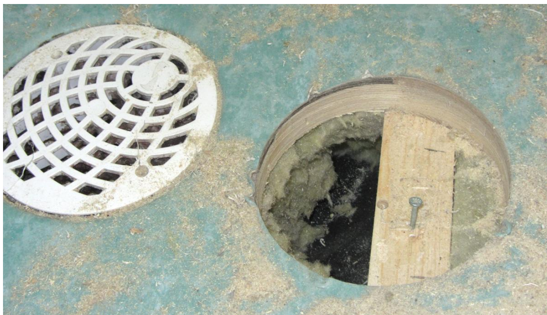
Figur 3.1.9.5 – Golvbrunn i våtrum. Uppmätt fuktkvot i golvregel 6%.
