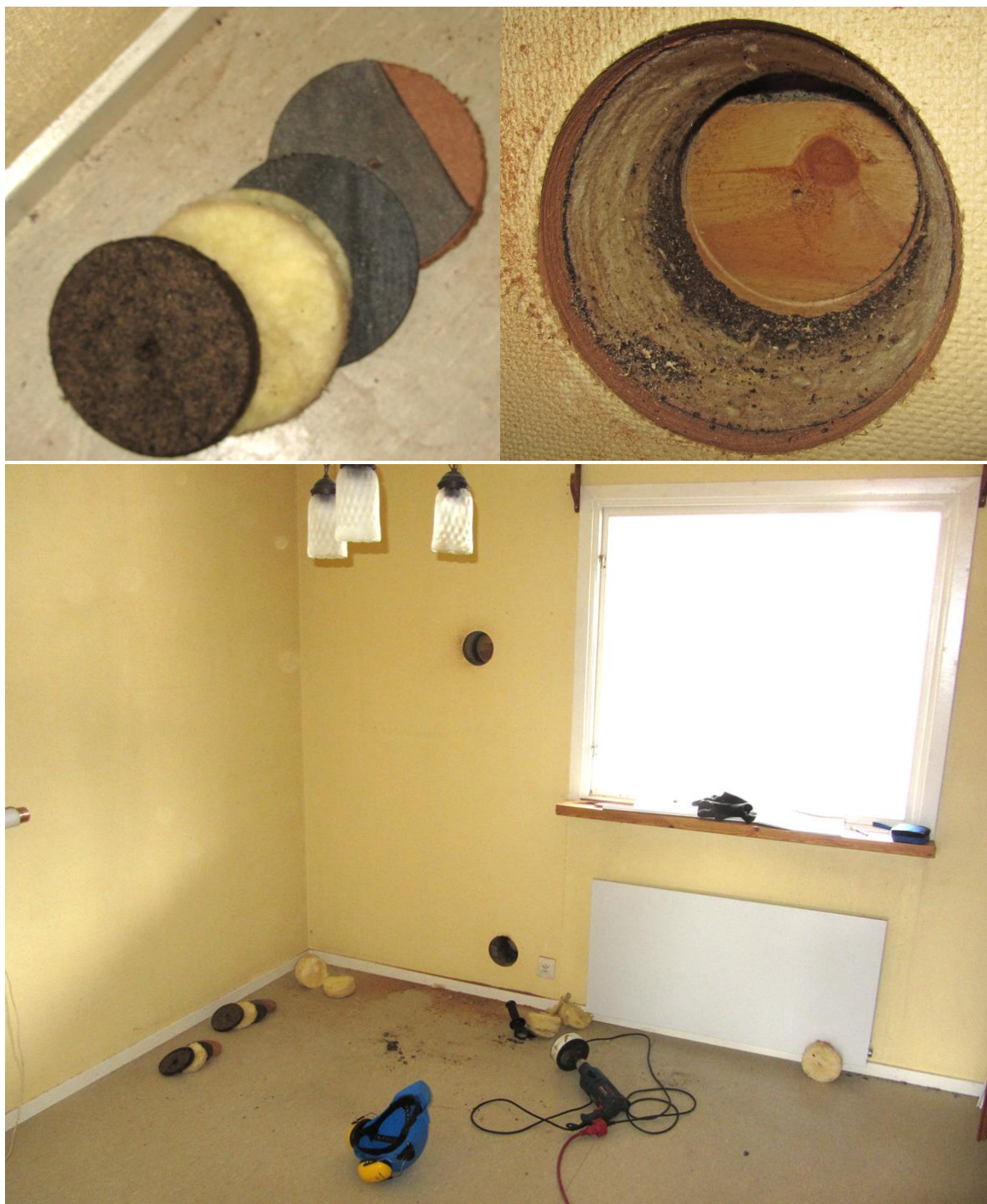
Figur 3.1.12.4 – Provtagning i sovrum sydöst, i södervägg, övre bilden från övre hålet. Uppmätt fuktkvot i ytterspont 9%.
