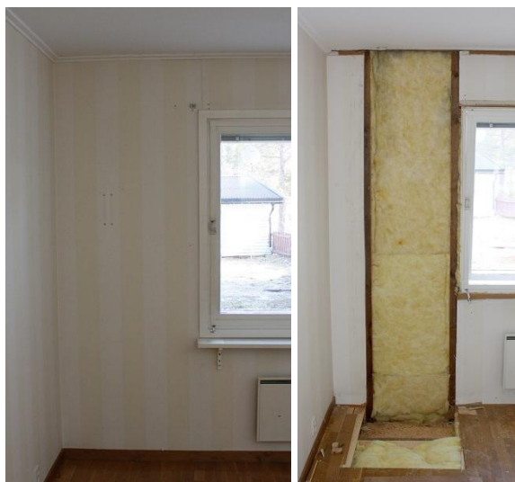
Figur 1.1.1.2 - Orörd vägg och med borttagen träfiberskiva och därunder synliggjord glasfiberisolering.
