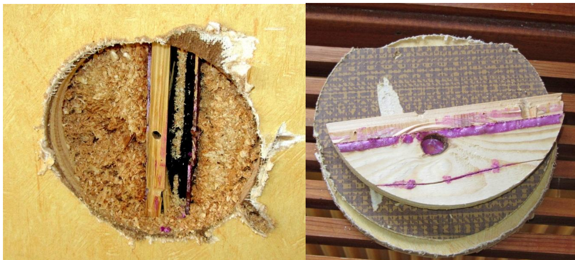
Figur 3.1.14.5 – Provtagning i vardagsrum i norr.
