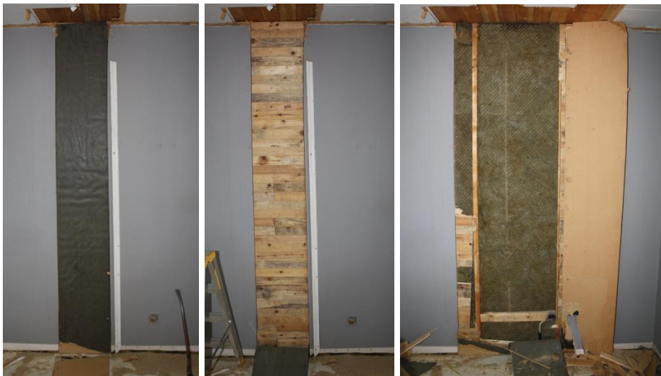
Figur 3.1.7.2 - Under mjuk träfiberskiva hittas: förhydringspapp, liggande återanvänd spontad formplank, mineralullsisolering.
