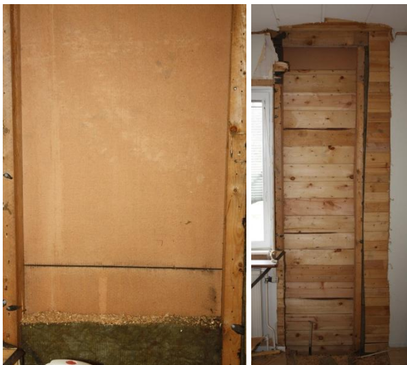
Figur 3.1.5.3 - Bakom mineralullen finns ytterligare en mjuk träfiberskiva, luftspalt, liggande spontad panel.
