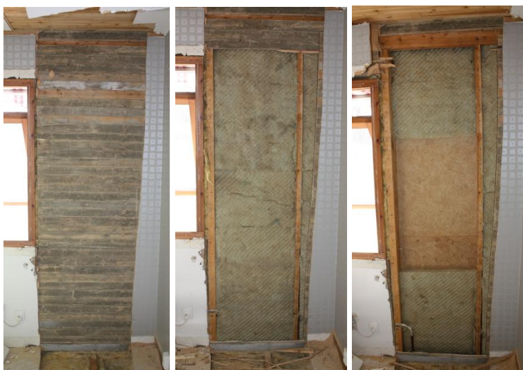
Figur 3.1.3.2 - Efter att träfiberskivan tagits bort syns i ordning: liggande spontade brädor, mineralull i tvålager och därunder mjuk träfiberskiva.
