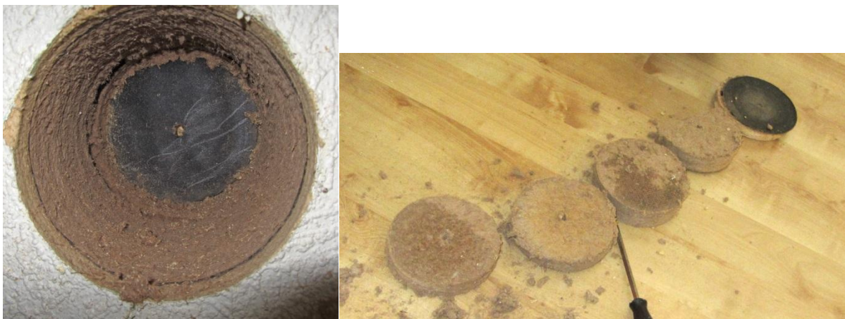
Figur 3.1.13.5 – Provtagning i sovrum nordväst, norra väggen nära golv.
