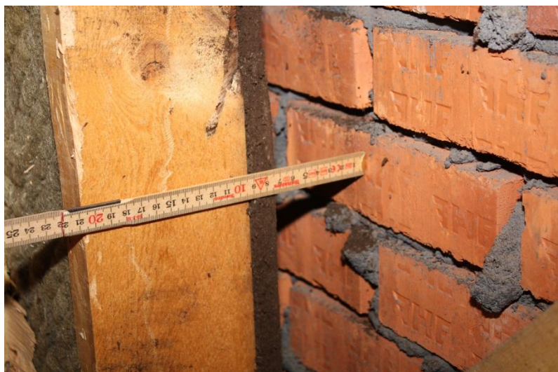
Figur 3.1.7.4 - Utifrån: murverk, luftspalt, asfaboard, regel.
