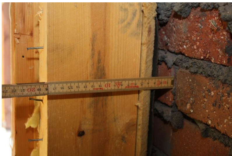
Figur 3.1.3.4 - Från utsidan: murverk, luftspalt, asfaltsimpregnerad papp, mjuk träfiberskiva, stående träregel.
