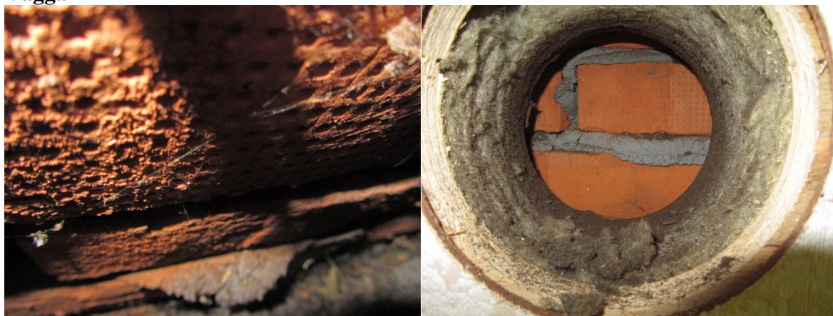
Figur 3.1.11.6 – Provtagning i sovrum i öster norr om entré. Uppmätt fuktkvot i syll och innervägg 7%. Isolering 10 cm. Asfaboard. 4 cm spalt.
