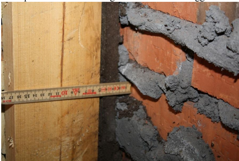
Figur 3.1.2.4 - Från utsidan: murverk, luftspalt, asfaboard, regel.
