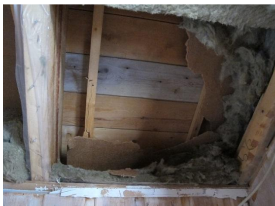
Figur 3.1.11.4 – Parallelltak upptaget ända ut till råsponten.
