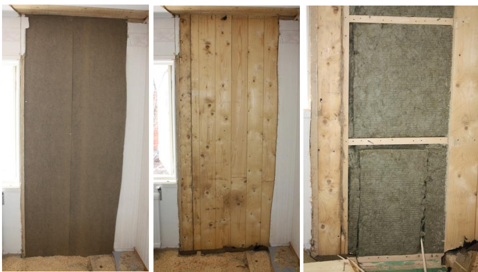
Figur 3.1.4.2 - Efter att träfiberskivan tagits bort syns i ordning: förhydningspapp, stående spontade plank och mineralull.
