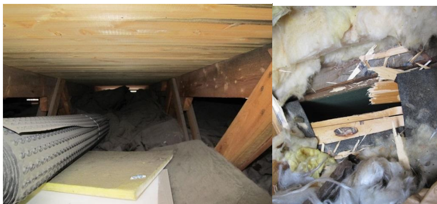
Figur 3.1.12.3 – Den låglutande vinden och snitt ner till träpanelen genom pappen.
