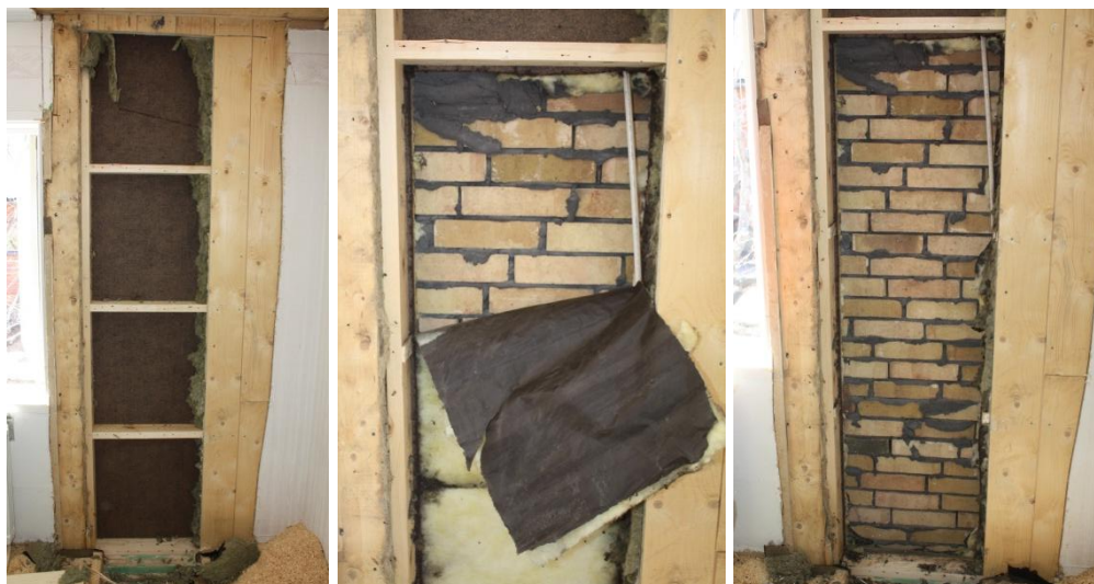
Figur 3.1.4.3 - Utanför mineralullen syns asfaboard, mjuk glasfiberull med asfaltimpregnerat papper vänt utåt samt halvstens murverk av tegel.
