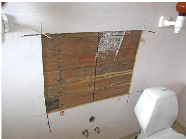
Figur 3.1.10.5 – Provtagning i innervägg i badrum i öster. Uppmätt fuktkvot 7%
