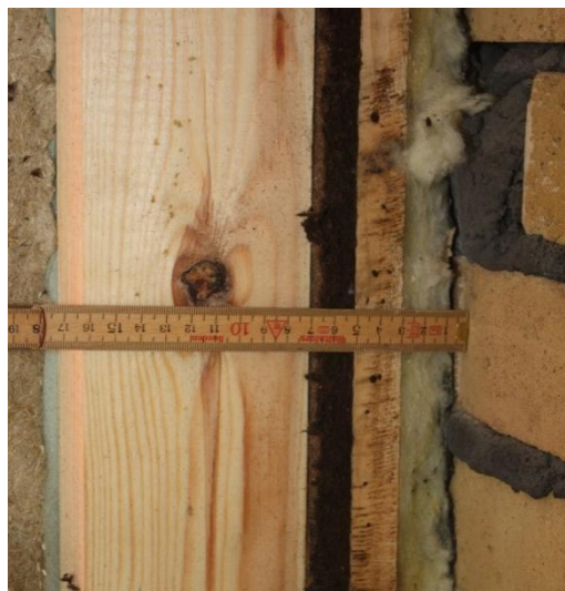
Figur 3.1.4.4 – Synligt på bilden finns uppräknat utifrån: murverk, mjuk glasullsisolering med asfaltspapp dikt an murverket, asfaboard fäst med läkt mot stående reglar.
