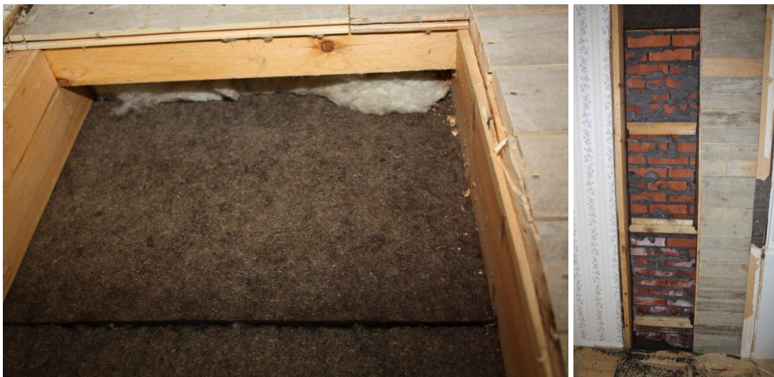
Figur 3.1.2.3 - Asfaboard följt av murverk.
