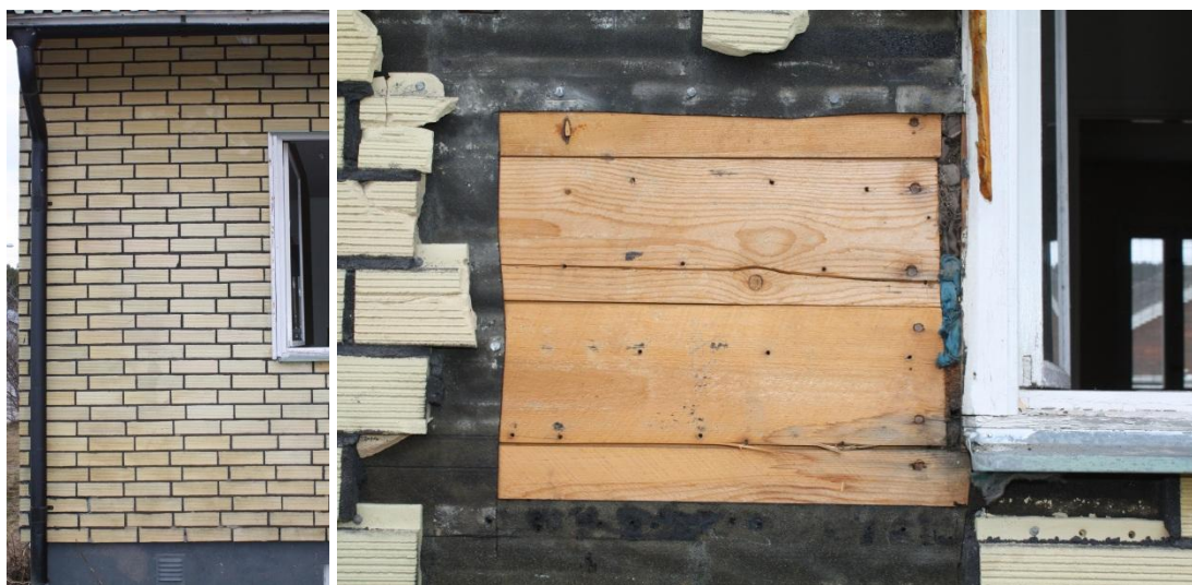
Figur 3.1.5.4 - På liggande träpanel med asfaltpapp sitter fasadplattor i tegel spikade.
