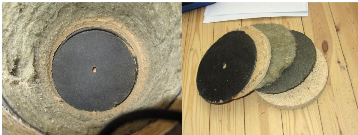
Figur 3.1.9.4 – Provtagning i vägg i sovrum i nordväst. Uppmätt fuktkvot 7% i ytterspont.
