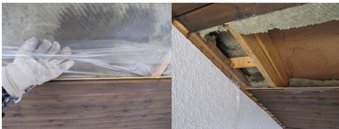
Figur 3.1.11.5 – Parallelltak där glipan i plastfolien syns tydligt.
