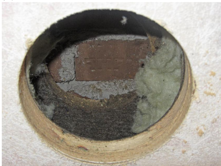
Figur 3.1.10.4 – Provtagning i underkant i yttervägg i sovrum mot nordöst. Uppmätt fuktkvot i syll var 8% och i ytterspont 9%.
