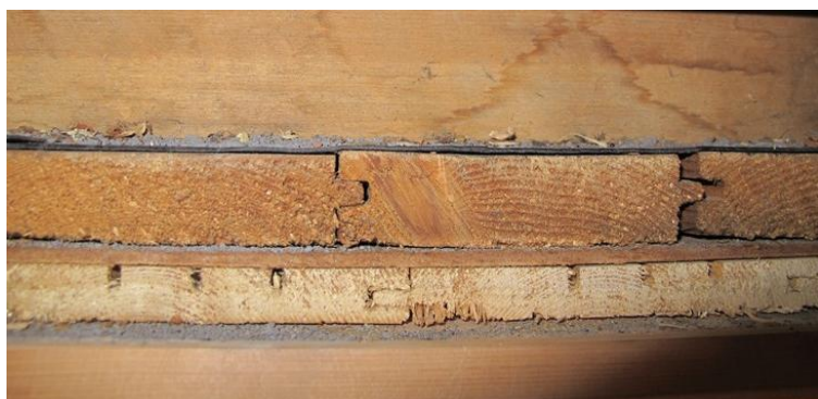
Figur 3.1.3.6 – Snitt genom vindsbjälklaget.
