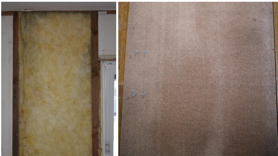
Figur 3.1.1.6 - Hål efter mollypluggar och skruv syns längst ner till vänster på isoleringen samt till vänster på träfiberskivan.
