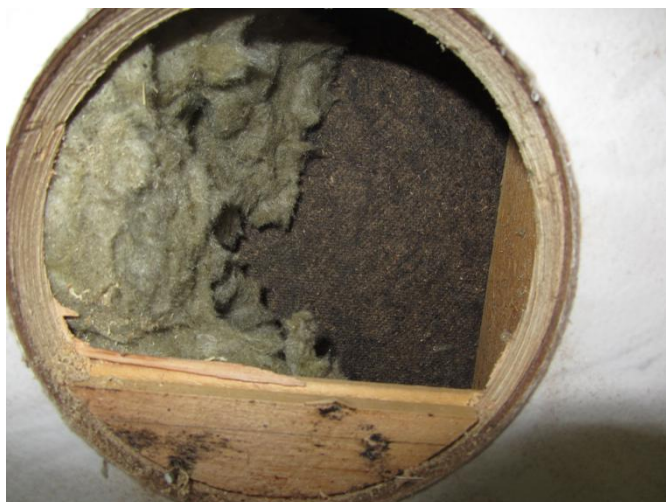
Figur 3.1.11.7 – Provtagning i badrum i norr intill fönster. Uppmätt fuktkvot i innerregel 6%. Duschkabinn fanns.
