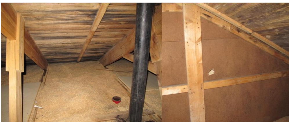
Figur 3.1.13.4 – Kaffeburksventilation och märke efter provtagning.
