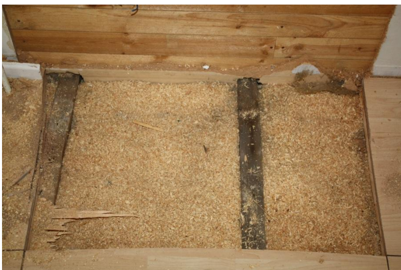
Figur 3.1.5.6 - Kraftigt missfärgade reglar hittas under golvplanken.
