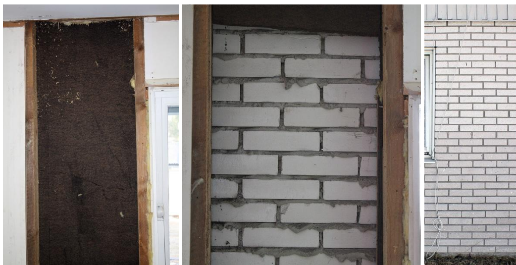
Figur 3.1.1.3 - Asfaboard bakom isoleringen och bakom denna kalksandsten med måttliga brukstuggor. Väggens utsida med färgskiftning.
