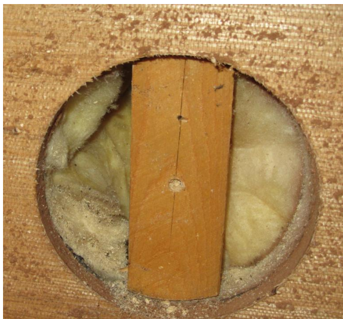
Figur 3.1.12.5 – Provtagning i sällskapsrum i söder mitt under fönster. Uppmätt fuktkvot i innerregel 7%.
