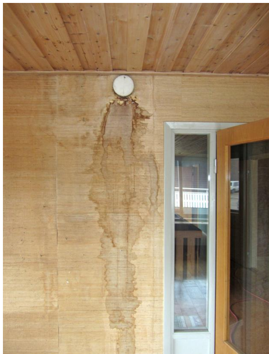
Figur 3.1.12.7 – Fuktskada troligen från rinnande vatten från ventil i sällskapsrum.
