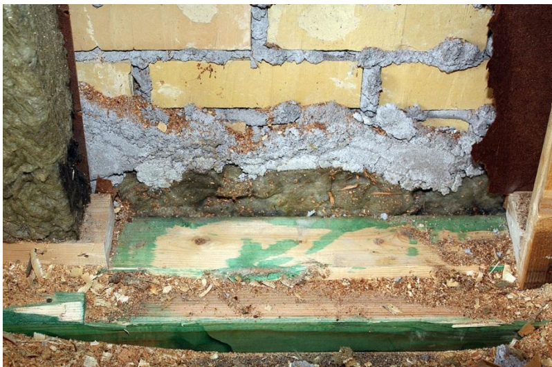
Figur 3.1.6.5 – Nedre delen av den yttre luftspalten är igensatt med isolering och bruk.
