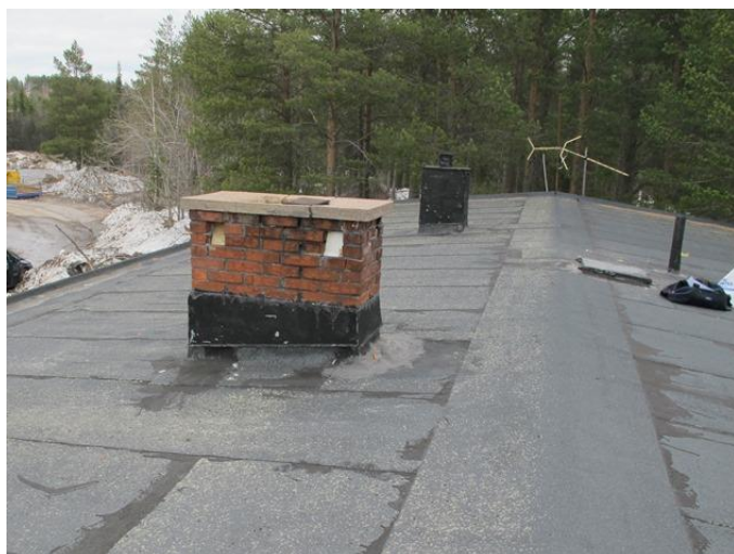
Figur 3.1.12.2 – Taket med lucka.
