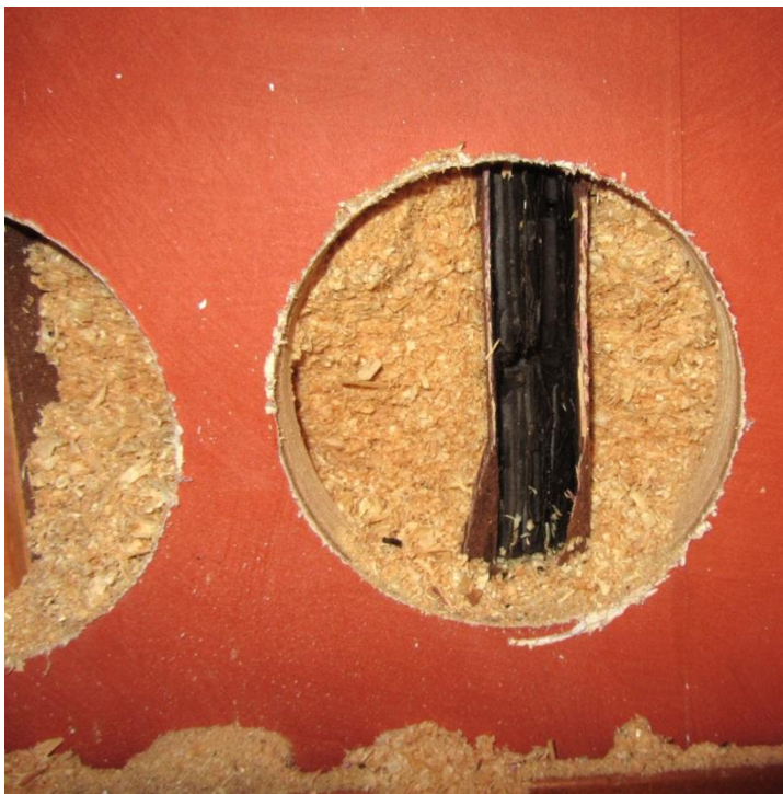
Figur 3.1.14.4 – Provtagning i sovrum i väster. 16 cm kutterspånisolering, 25 mm träplywood och lättrégel.
