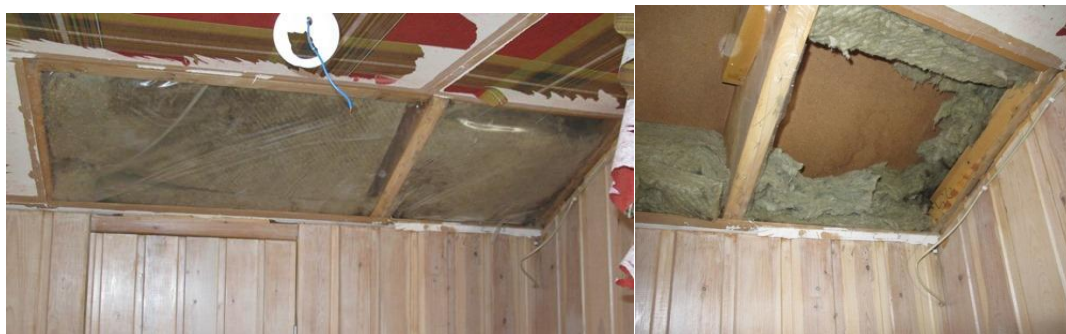
Figur 3.1.11.3 – Parallelltak där det syns att isoleringen varit utsatt för vatten samt att träfiberskivan är angripen.
