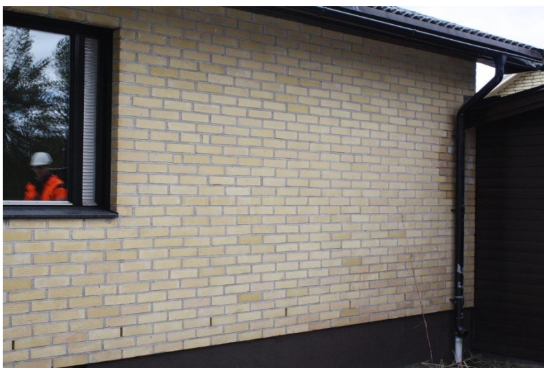
Figur 3.1.6.6 - Tegelfasaden har öppna stötfogar på utsidan.
