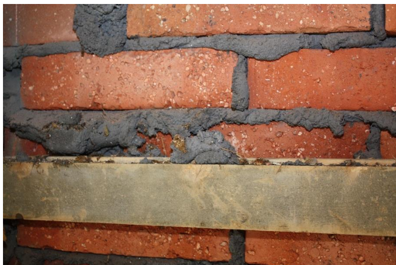
Figur 3.1.3.5 - Luftspalten mot murverket är horisontellt avgränsad av klyvda formplank. Bruk och växt-delar återfinns ovanpå.
