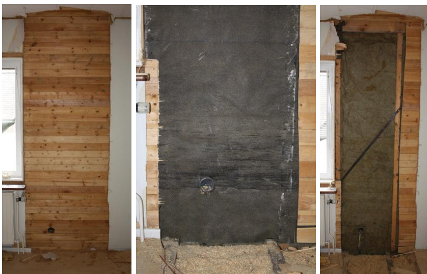
Figur 3.1.5.2 - Bakom mjuk träfiberskiva finns: liggande spontad träpanel, förhydningsspapp, mineralull i tvålager.
