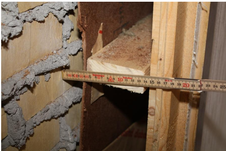
Figur 3.1.6.3 - Från utsidan: murverk, luftspalt, härdad board, liggande regel och mineralull (borttagen), stående plank, mjuk träfiberskiva.
