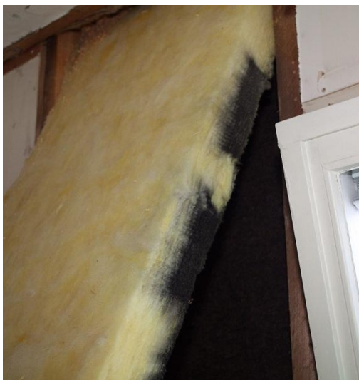
Figur 3.1.1.7 - Nedsmutsning av isoleringen misstänks bero på damm från asfabord som följt luftläckage in i ytterväggen.
