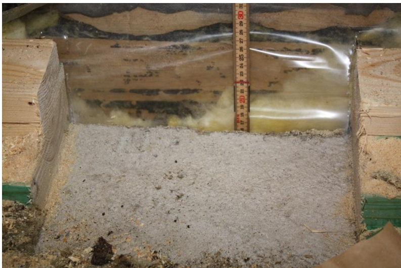
Figur 3.1.4.5 - Plastfolie är placerad för att leda ut vatten från syllen.
