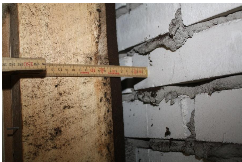
Figur 3.1.1.4 - Från väggens utsida: murverk, luftspalt, asfiboard, stående träregel.
