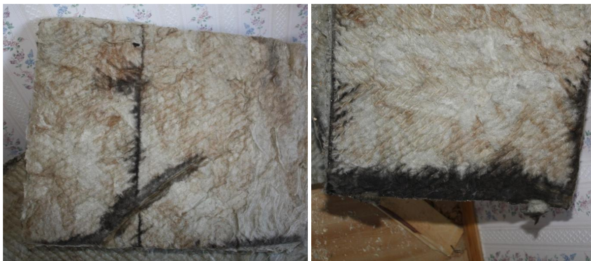
Figur 3.1.2.5 - Nedsmutsning av mineralullen syns längs skarvar i asfaboarden och har spridits där utrymme funnits mellan isolering och board.
