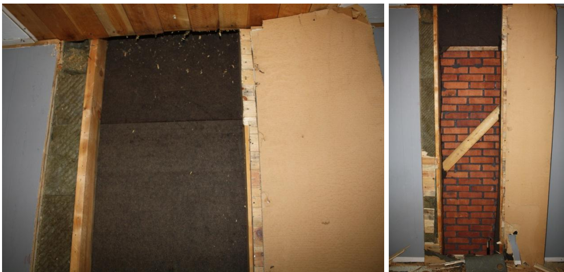
Figur 3.1.7.3 - Asfaboard följs av luftspalt och murverk.
